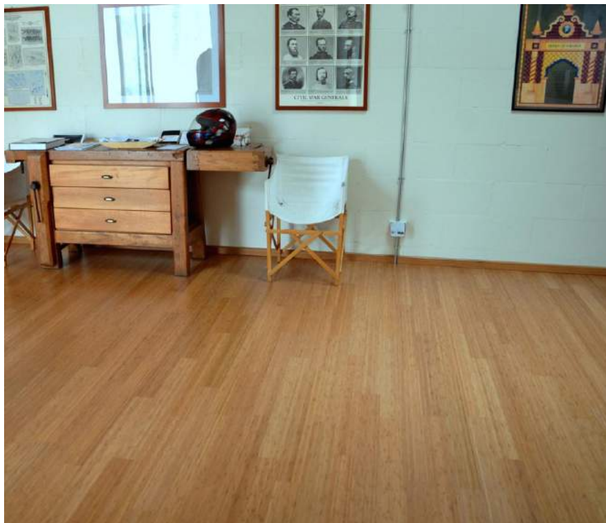
Pavibamboo a 2 strati incrociati posato su pavimento radiante
